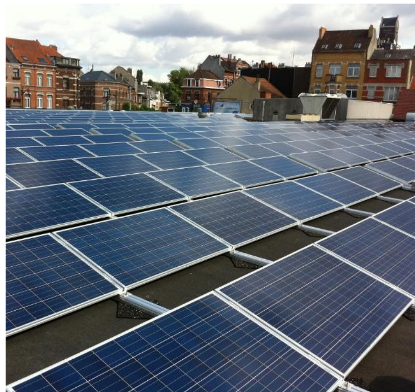
Toiture école Nos Bambins
