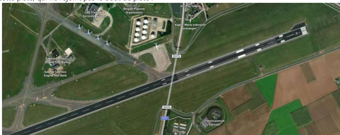
Figure 60 : Seuil de piste 25L et taxiway
