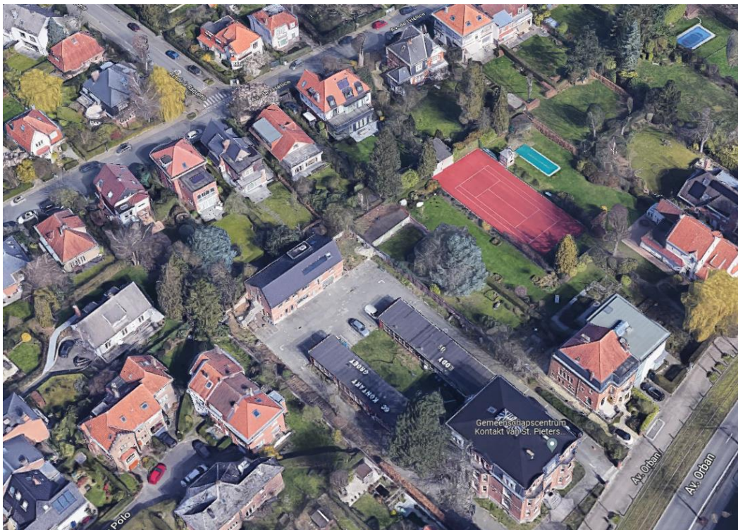
Figuur24: Verharding van de bodem Orbanlaan (bron: Google street view)
