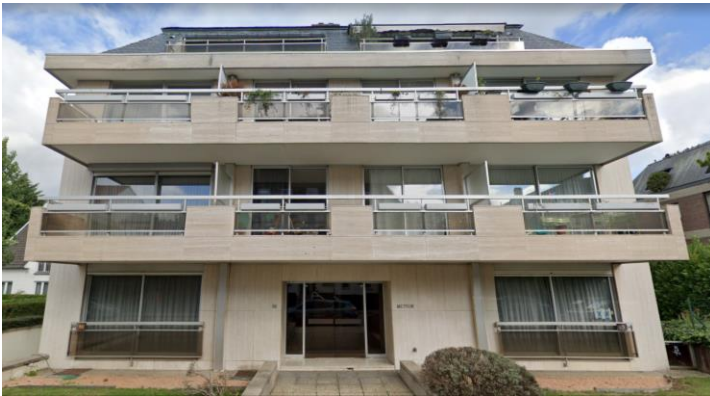
Figuur 11: Voorbeeld van een problematisch gebouw dat wel in overeenstemming is met de GSV (bron: Google street view)
